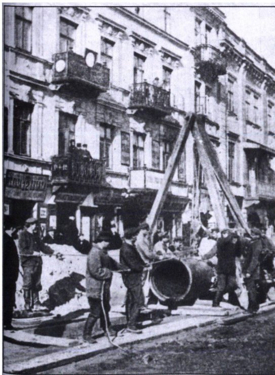
Строительство водопровода в Варшаве, 1888
