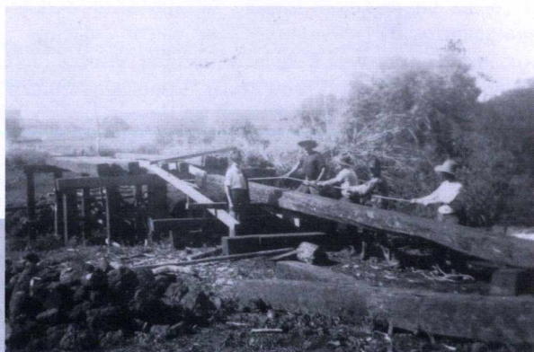
Строительство моста над рекой Рио-сень-Пейше на линии Примейро-де-Марсо в 1930 г.
