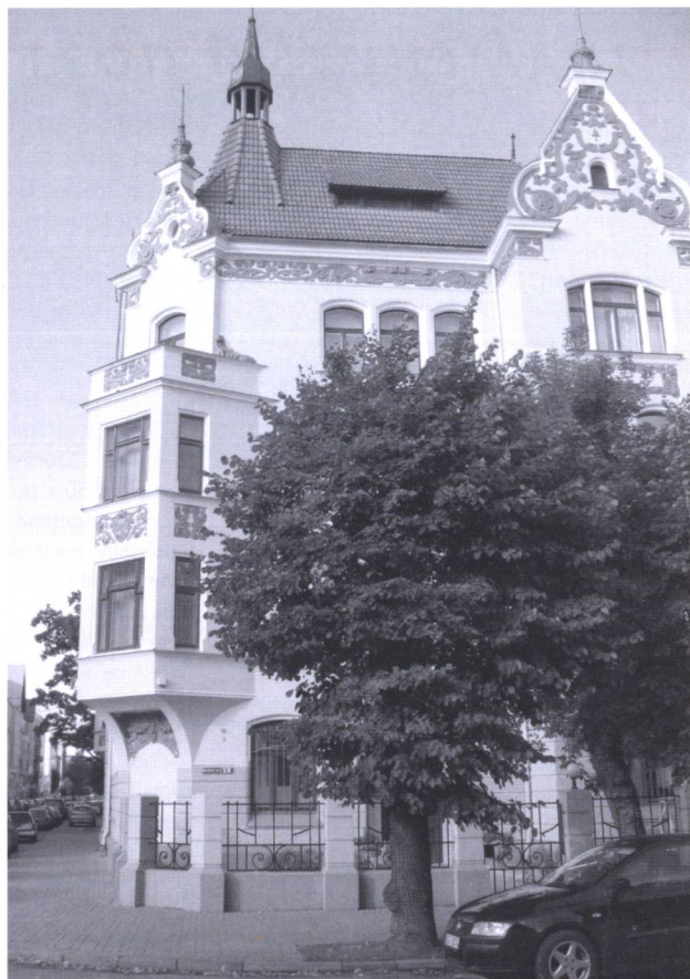
Рижский дом, в котором сорок с лишним лет проживала семья Задорновых (ул. Элизабетес, 13).
